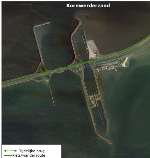
Figuur 20: Tijdelijke fietsbruggen langs de spuisluizen Kornwerderzand.
