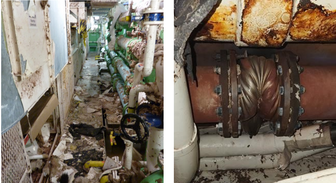
▲ Figuur 3: Links de situatie in voorste afvalwaternruimte na het voorval (bron: Onderzoeksraad voor Veiligheid). Rechts: Het expansiestuk zoals het werd aangetroffen (bron: Holland America Line).
