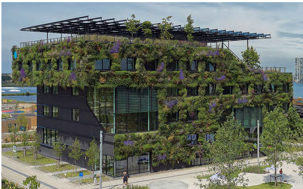
Figuur 8-11 Nature Based Solution, verkoeling en energiebesparing met groen bij Aeres Hogeschool in Almere (bron https://www.werklandschappen.nl/innovatiedatabase/dubbelfunctie-zonnepanelen-als-schaduw-dak-en-zonwering/ )
