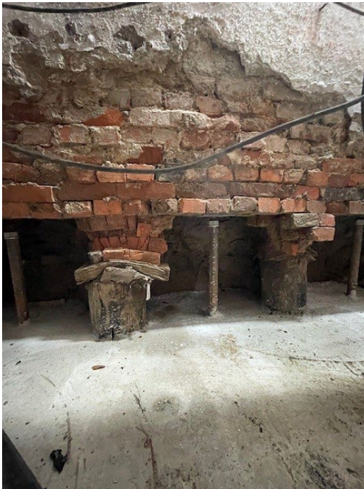
De foto links in figuur 2.4 toont schade aan een gebouw met houten paalfundering, de foto rechts toont een gebouw met een ondiepe fundering.
