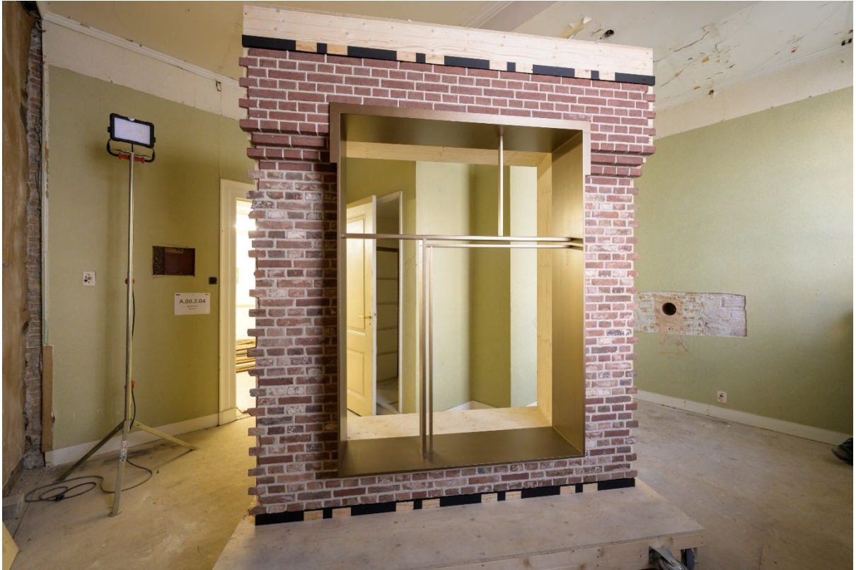
(Afbeelding 7: proefopstelling nieuwe kozijnen souterrain Raad van State)
