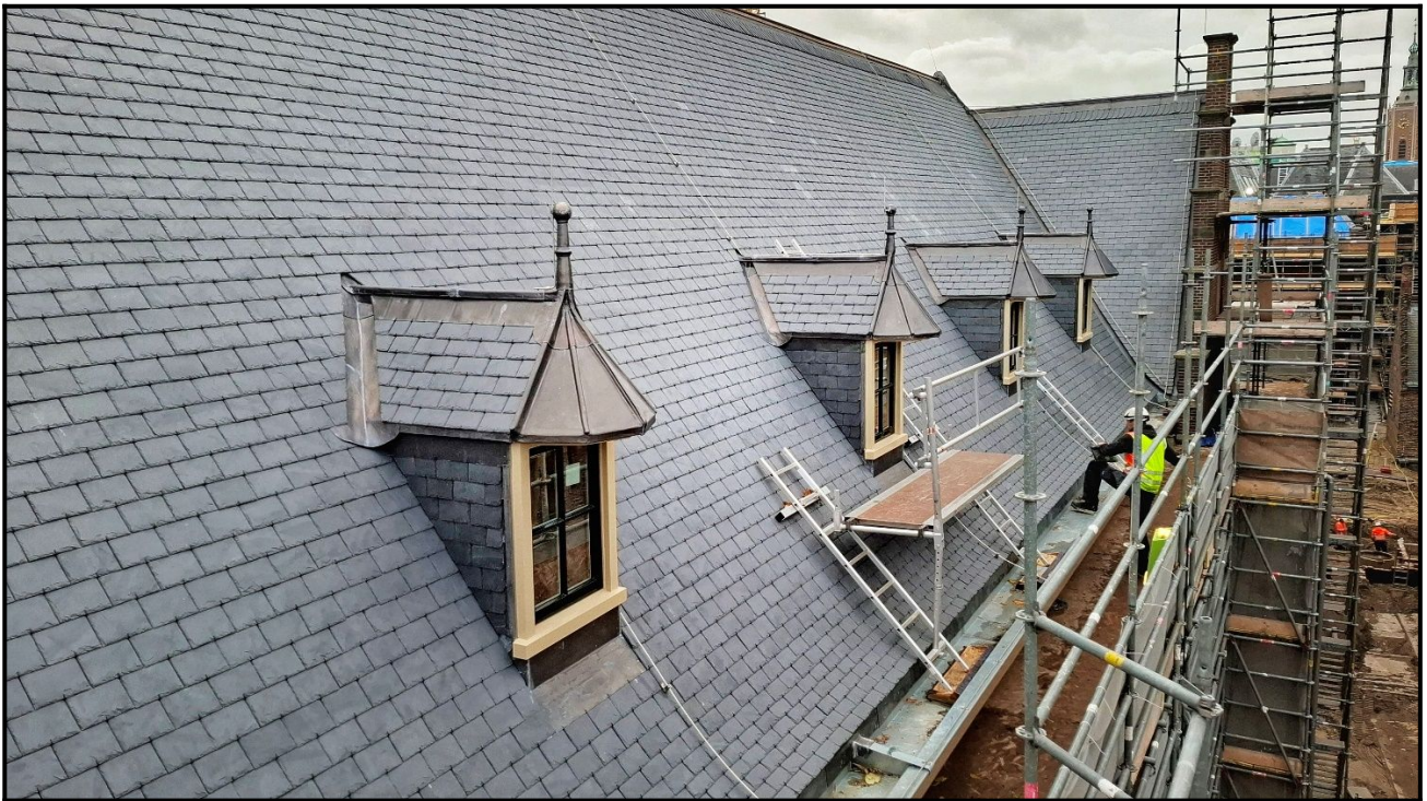
(Afbeelding 1: Het dak van gebouw C; na de isolatie worden de leien gelegd waarmee de daken zijn hersteld)
