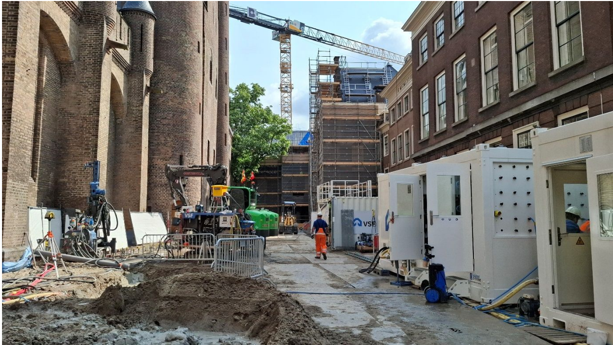
(Afbeelding 10: funderingsversterkingen Grafelijke Zalen)
