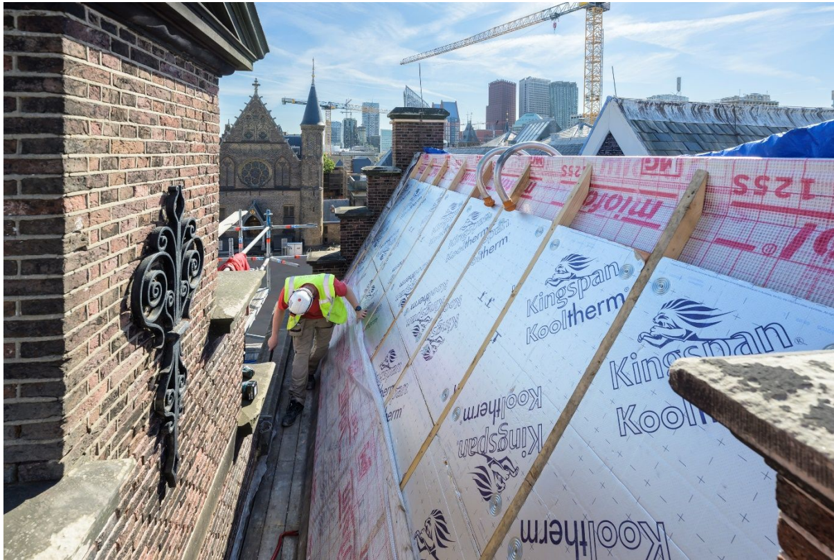
(Afbeelding 6: Renovatiewerkzaamheden Raad van State)
