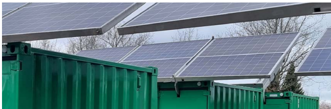
Zeecontainer als duurzaam energiesysteem
