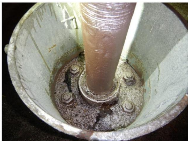
afbeelding 21: onthechte waterafdichting (west-15)
