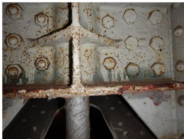
afbeelding 7: afbladderende toplaag
