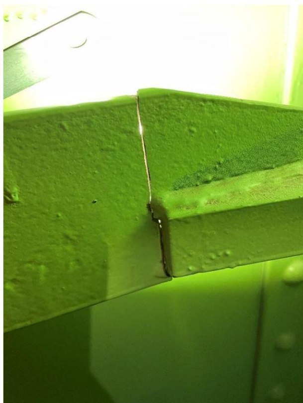
afbeelding 33: gebroken plooverstijver
