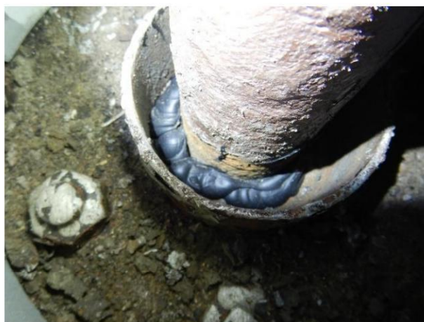
afbeelding 14: waterafdichting (west-27)
