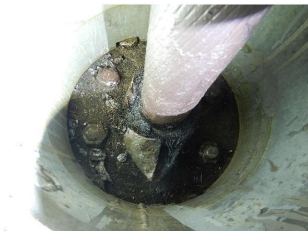
afbeelding 13: waterafdichting (west-32)
