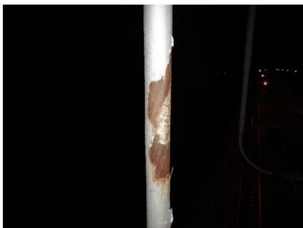
afbeelding 3: afbladderende conservering
