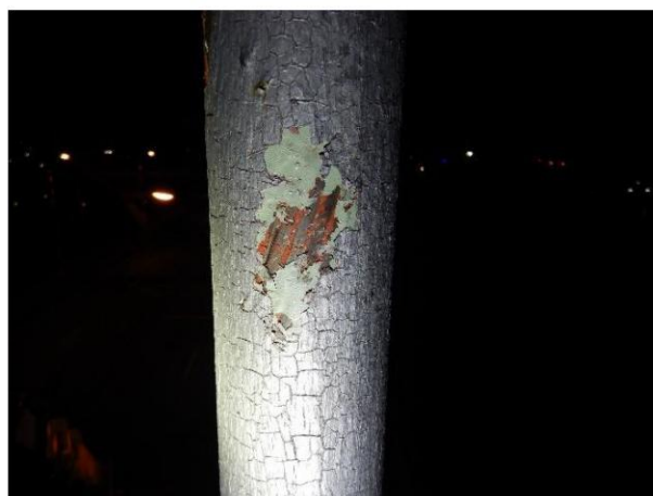
afbeelding 4: onthechte conservering, gecraqueleerde toplaag
