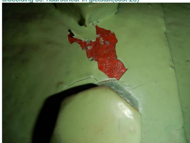
afbeelding 32: haarscheur in gietstuk (oost-22)
