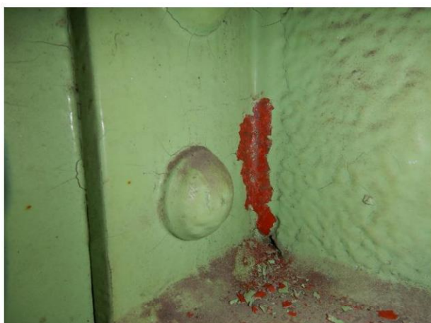
afbeelding 25: scheurtjes in conservering, niet in staal (oost-24)
