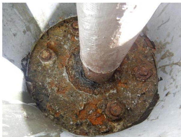
afbeelding 10: bouten moeren (bevestiging gietstuk)
