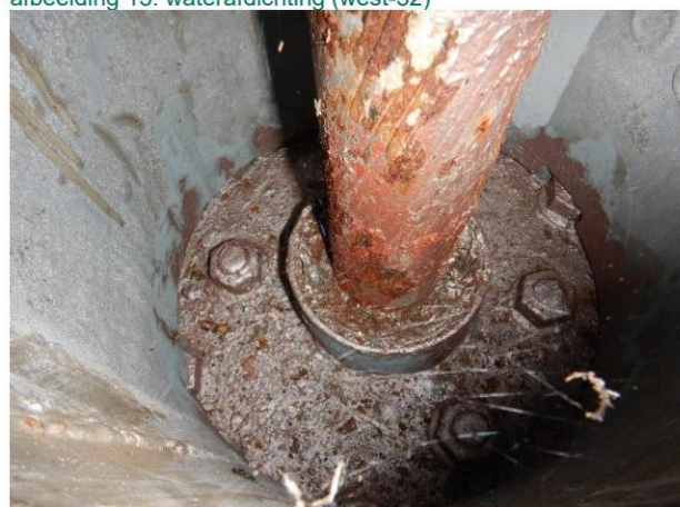
afbeelding 15: waterafdichting (west-25)
