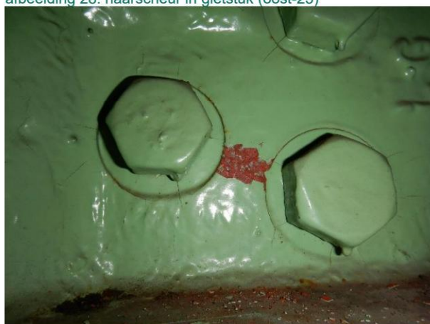
afbeelding 30: haarscheur in gietstuk(oost-23)
