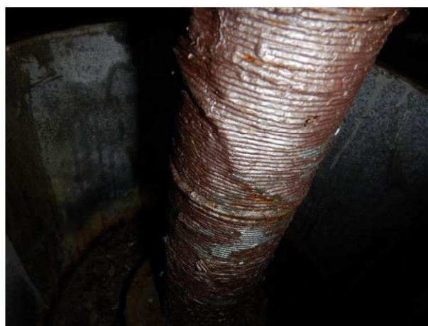
afbeelding 12: oneffen uitvoering thermisch verzinkte draad
