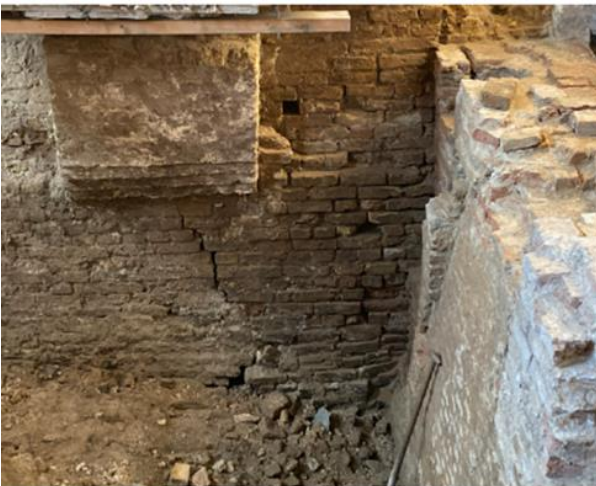
Scheuren en lekkages kelder EK en RvS
