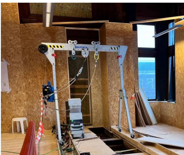
Veiligheidsportaal en proefopstelling warmte-element
