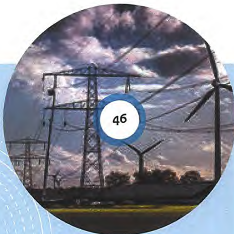
380 kV hoogspanningsverbinding Diemen, Lelystad en Ens
