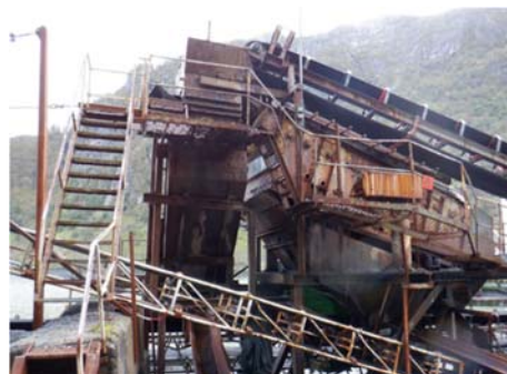
Eikefet: 2 wassers, nadere inspectie niet mogelijk
