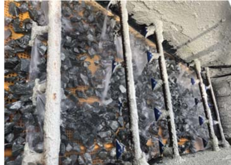
Amsterdam (Bremanger/Glensanda): 1 wasser met 5 buizen x 5 sproeiers
