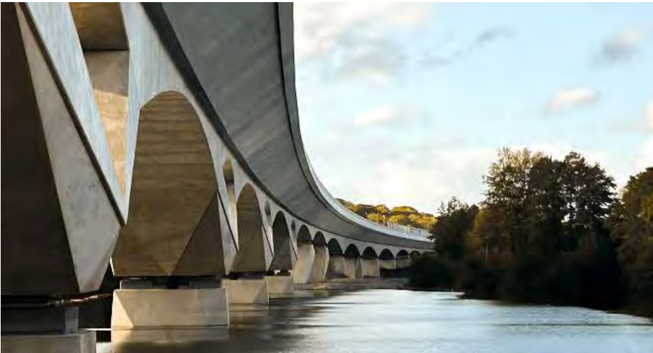
Hoogwaardige afwerking van nieuw spoorviaduct. HS 2, Colne Valley, Verenigd Koninkrijk
