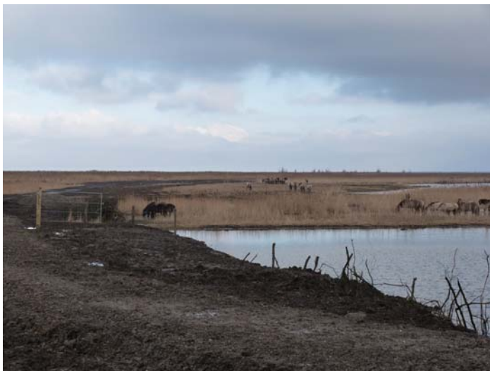
De aangelegde dam bij het Oostvaardersbos
