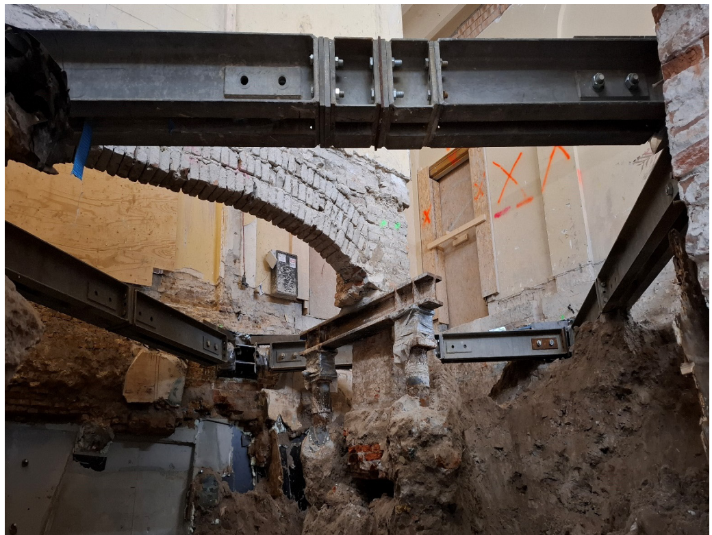
(Afbeelding 5: Nieuwe ondersteuning funderingen Eerste Kamer)
