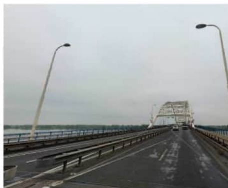
Foto 2: Overzicht bovenzijde kunstwerk.
