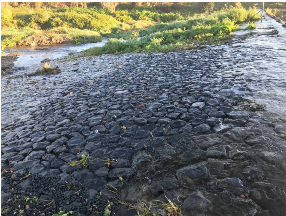
Figuur 4.9 Herstelde steenzetting, opvallend is dat ter plaatse van de herstellde steenzetting water tussen of onder de stenen doorstroomt en daarboven en daaronder over de steenbekleding.
