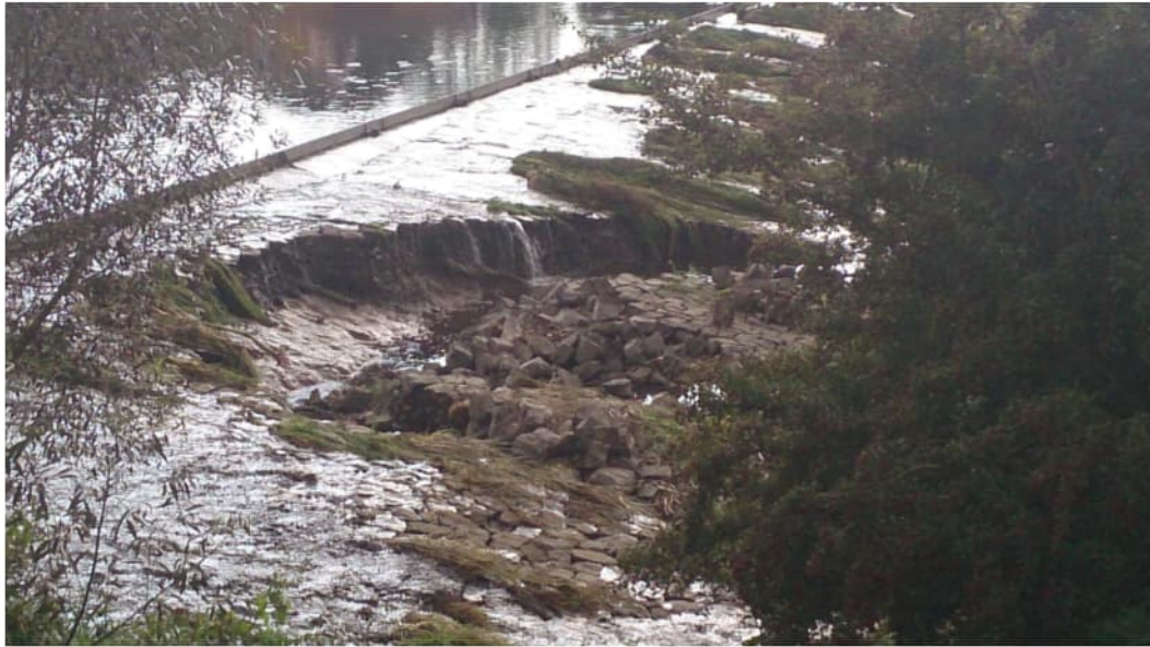
Figuur 4.2 Schade aan de overlaat, september 2014, bron RWS.
