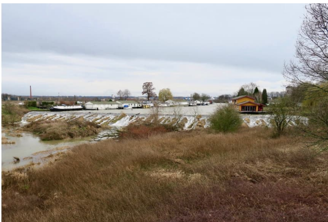
Figuur 2.11 Foto van de overlaat op 13 februari 2020.
