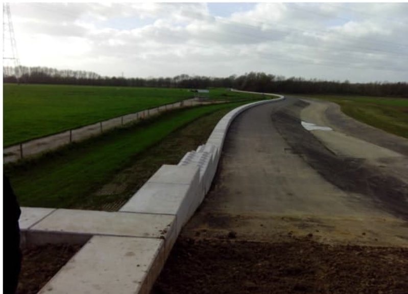
Figuur 6.11 Foto van inlaatlocatie/instroom/overlaat drempel LKW-Zuid (de instroming is van links naar rechts). Datum onbekend.
