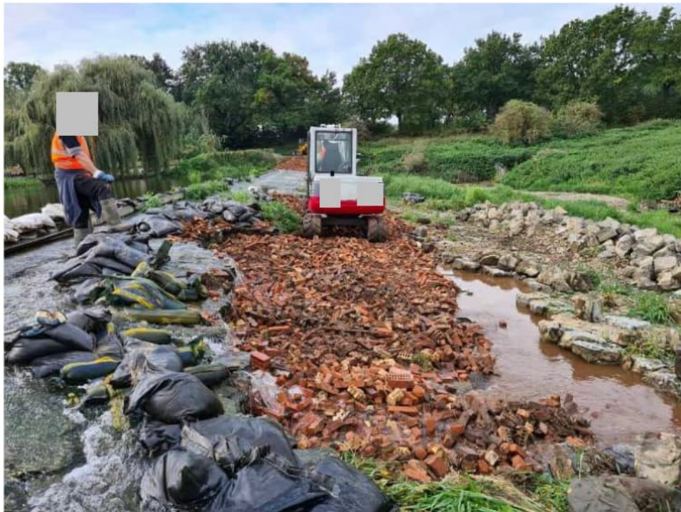
Figuur 4.7 Aanbrengen vlijlaag van puin.
