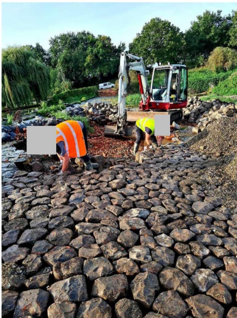
Figuur 4.8 Herstel bekleding met basaltzuilen.
