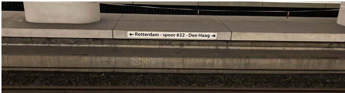
▲ Figuur 72: Oriëntatieborden in de tunnel bij Delft.
