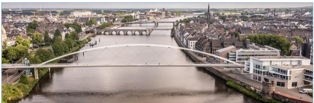
Figuur 3-1 De Hoge Brug in Maastricht
