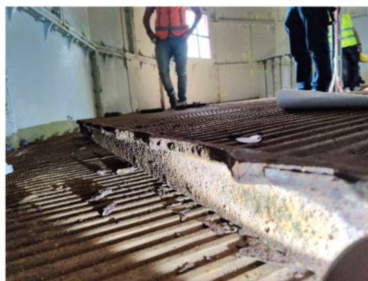
Foto 2: Scheuren blijven voor rib aan uiteinde
