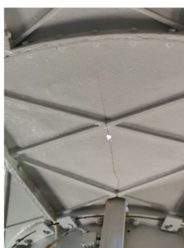
Foto 4: Scheuren in onderzijde vloer
