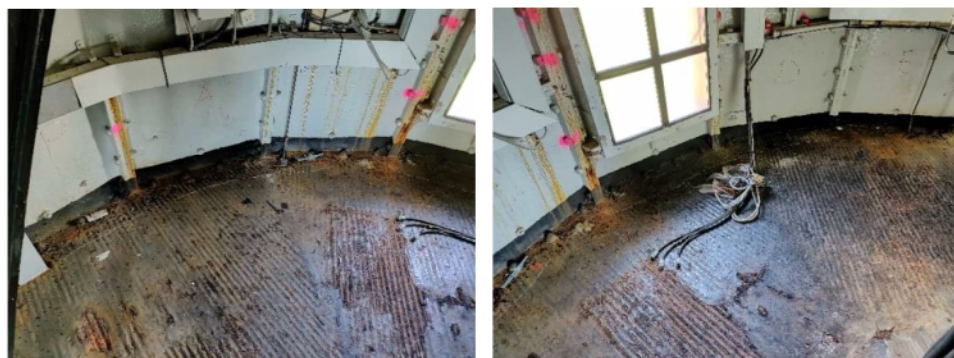
Foto 5 en 6: Scheuren langs de schachtwand
