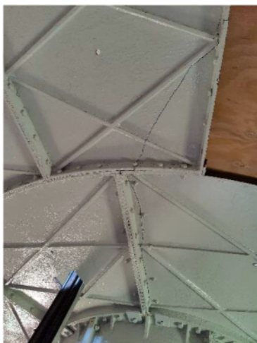
Foto 3: Scheur uitgehaald vloerdeel
