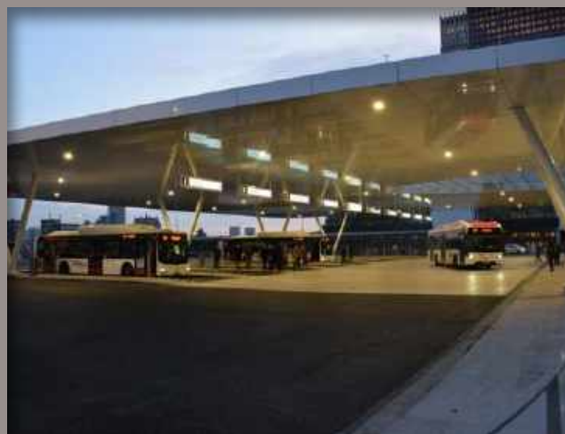
1. Opgetild busstation met overkapping
