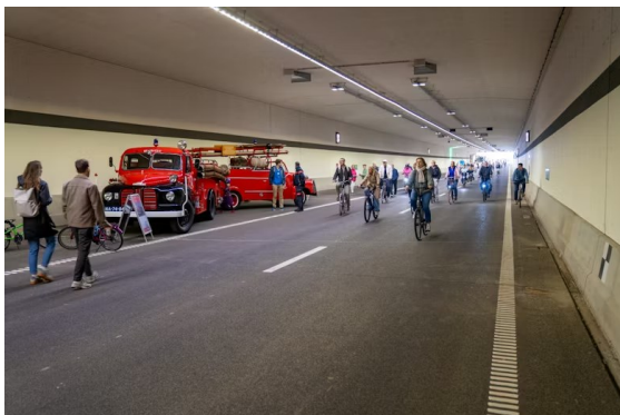
Figuur 28 Fietsen en lopen door de nieuwe Rottemerentunnel
