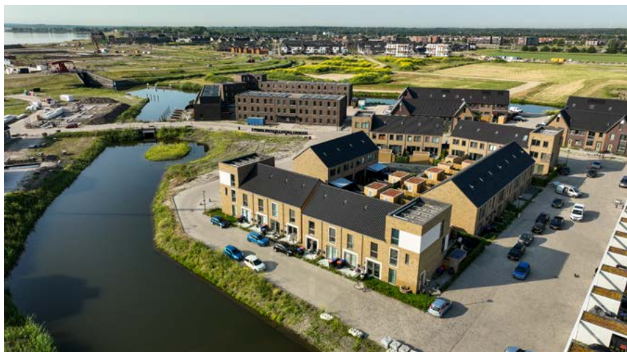
Foto: Heijmans Horizon woningen in Zeewolde.
