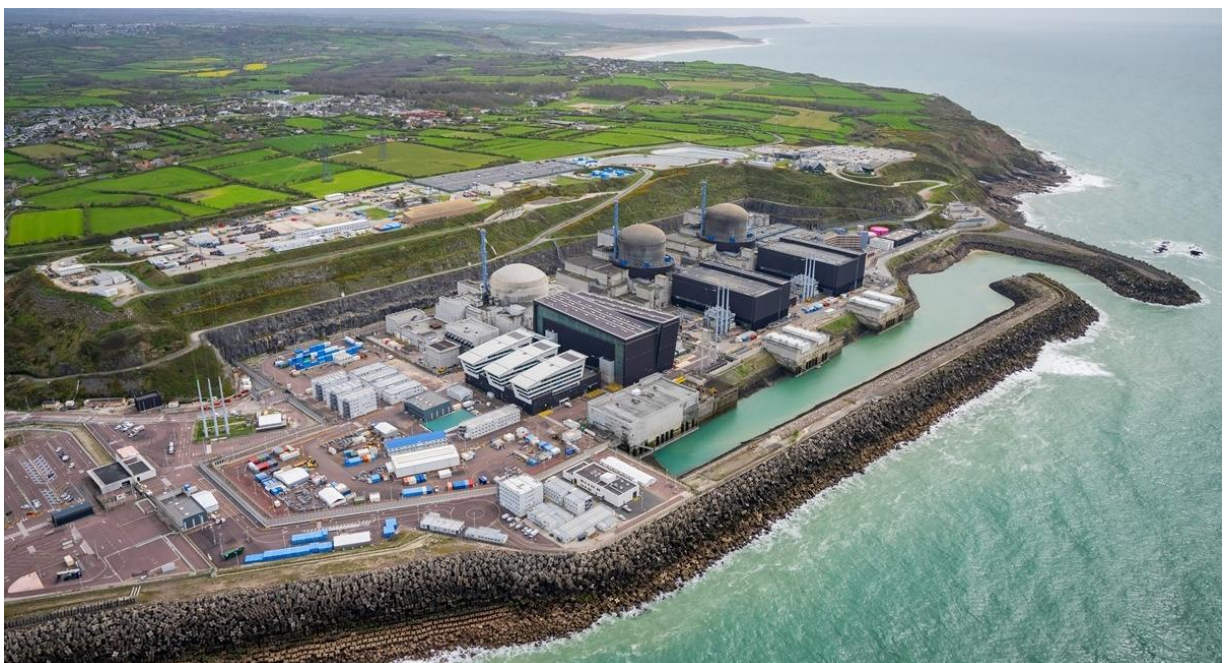
Figuur 3-6 Voorbeeld indicatie bedrijfsfase; Flamanville (bron: EDF-CNPE de Flamanville, 2019). Deze kerncentrales maken gebruik van open waterkoeling
