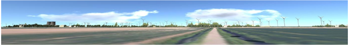
Figuur 21-3 Aanzicht Eemshaven 1B koeltorens (ca. 175 m hoogte t.o.v. maaiveld) vanaf Tweehuizerweg
