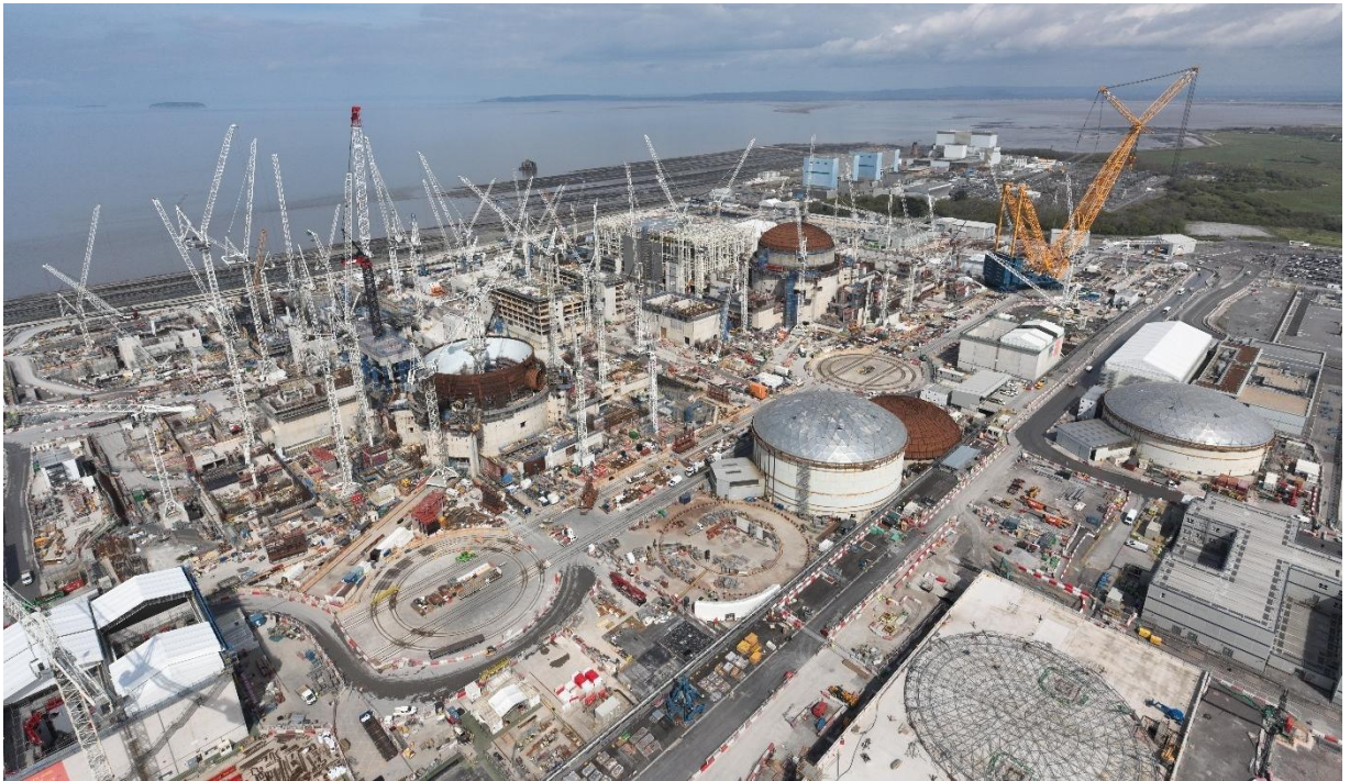
Figuur 3-3 Voorbeeld impressie bouwfase (EDF); Hinkley Point C (bron: EDF Energy, 2024)
