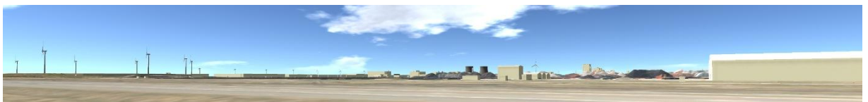
Figuur 21-6 Aanzicht Maasvlakte met koeltorens (ca. 175 m hoogte t.o.v. maaiveld) vanaf N15
