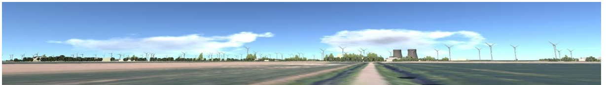
Figuur 21-5 Aanzicht Eemshaven 3 koeltorens (ca. 175 m hoogte t.o.v. maaiveld) vanaf Tweehuizerweg
