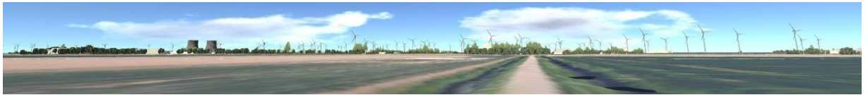
Figuur 21-2 Aanzicht Eemshaven 1A koeltorens (ca. 175 m hoogte t.o.v. maaiveld) vanaf Tweehuizerweg
