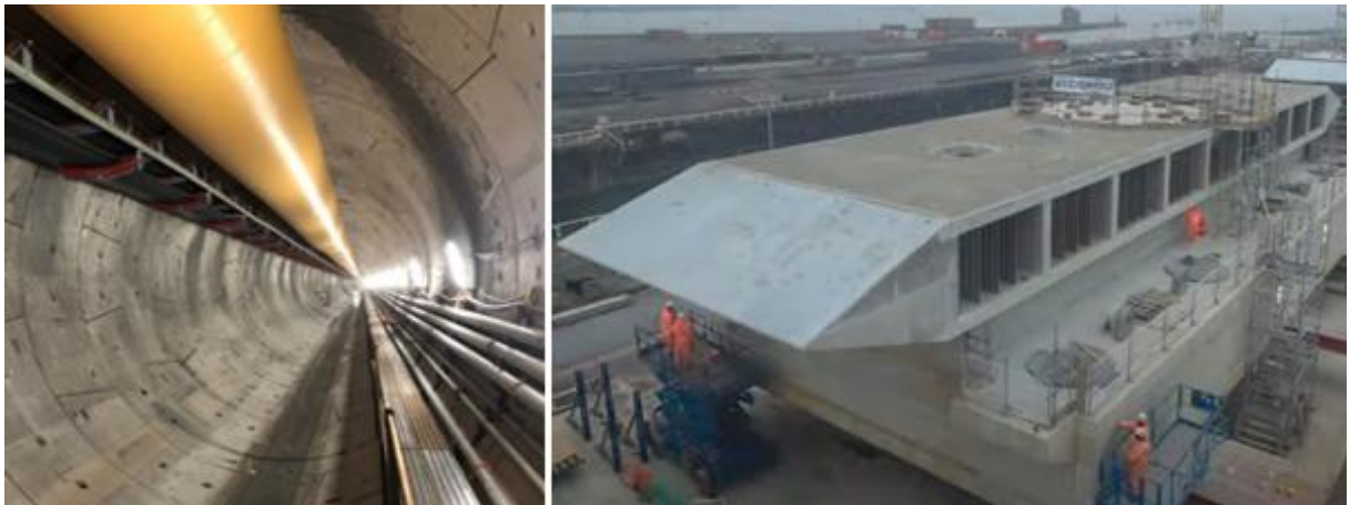
Figuur 20-4 Doorsnede van een tunnelbuis voor koelwater (links) en het bouwwerk voor de tunnelmond van de inlaat (rechts)
