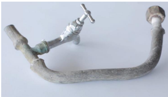
Figuur 3 : Loden leiding (bron: Drinkwaterplatform)
